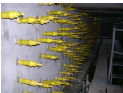
ー ひび割れ注入ー
