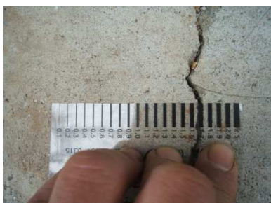
ー ひび割れ幅測定ー
