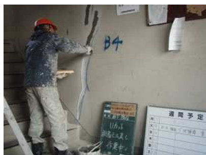
ー Uカットひび割れ補修ー
