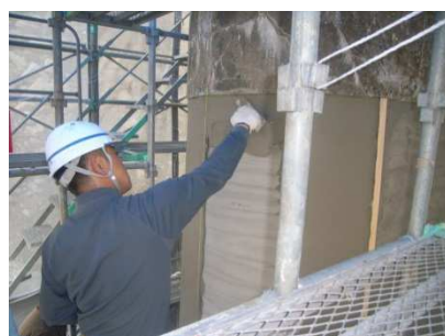
ー 断面修復（ポリマーセメント）ー
