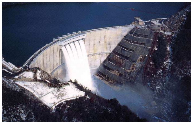
ー アーチ式コンクリートダム（温井ダム）ー
