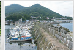
函館港改良工事
