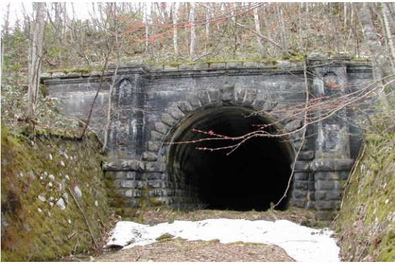
新内隧道入口
