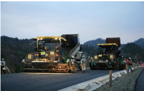
道東道舗装工事
