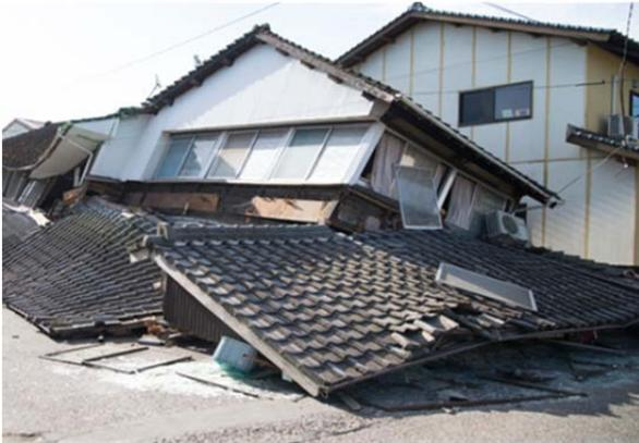
写真 1.1.1 揺れにより倒壊した家屋
