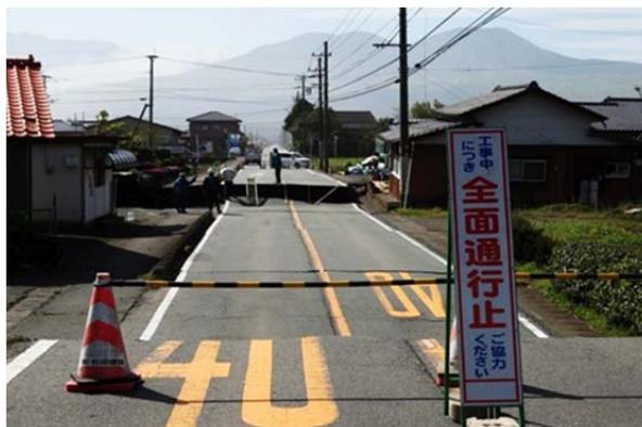
写真 1.1.3 道路の陥没
