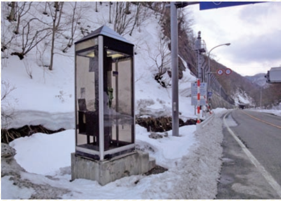
写真1 高い基礎台の上に設置された公衆電話ボックス(撮影：国道48号沿い(宮城—山形県境))
