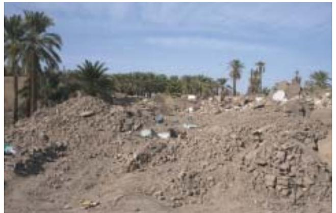
写真-7 アドベ住宅の倒壊状況
