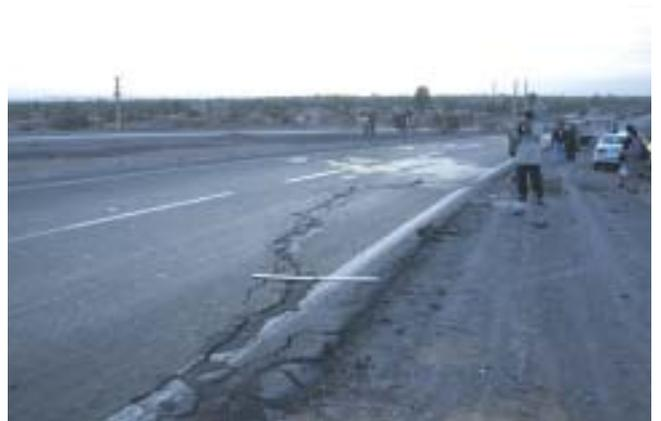
写真-2 撓曲崖を横切る道路の亀裂
