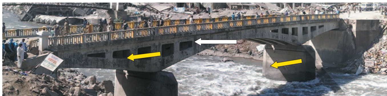
写真-1 バラコット橋の桁の移動
