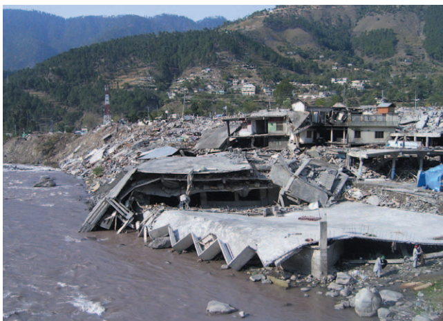
写真-5 バラコットにおける家屋の倒壊状況
