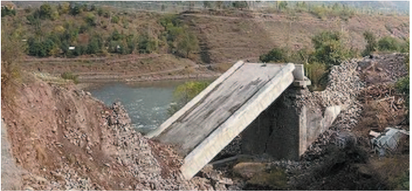
写真-2 橋台の崩壊による単純桁の落下
