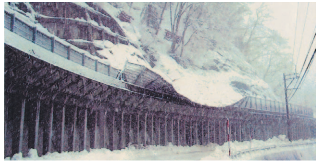
写真-8 表層雪崩による落石防護柵の倒壊(一般国道471号富山市八尾町栗須地内)(提供:富山県土木部)
