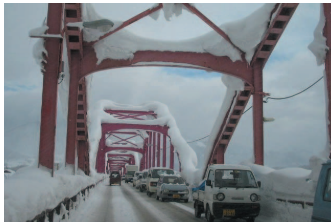
写真-6 一般国道403号のトラス橋上の冠雪(連続的な降雪と低温の影響により異常な冠雪)長野県飯山市中央橋(提供:長野県土木部)
