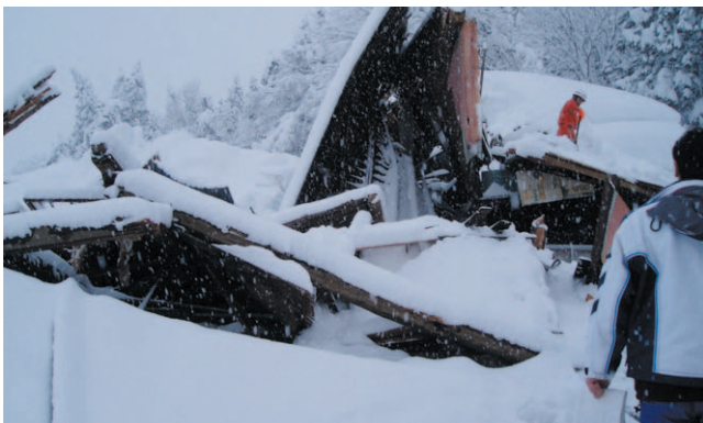
写真-7 雪の重さで倒壊した家屋、長野県飯山市内(提供:長野県飯山市)
