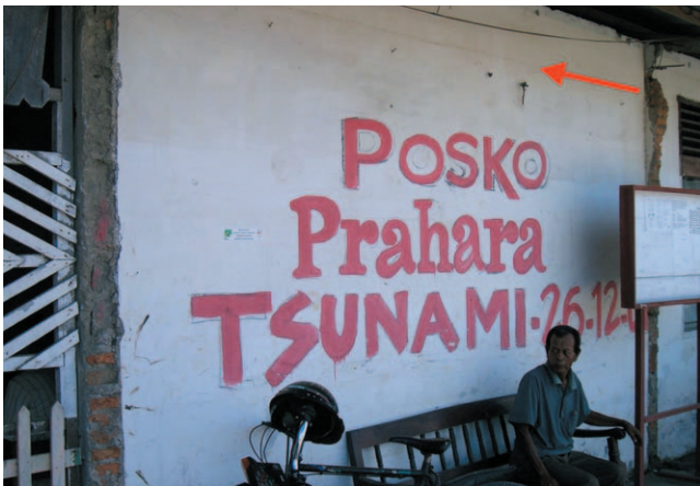
写真-3 ムラボーモスク横の建物に今も残る津波痕跡 (4° 8' N、96° 8' E)
