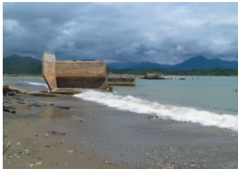
写真-4 ラムベウソ橋梁 (No.15)の被災状況 (5°3'N、95°20'E)
