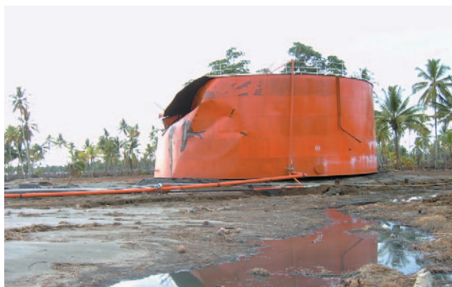
写真-7 被災後のパームオイルタンク
