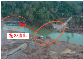
写真-5 ロッカチャ橋梁 (No.9) の桁の流出 (提供：国連) (5°22'N、95°16'E)
