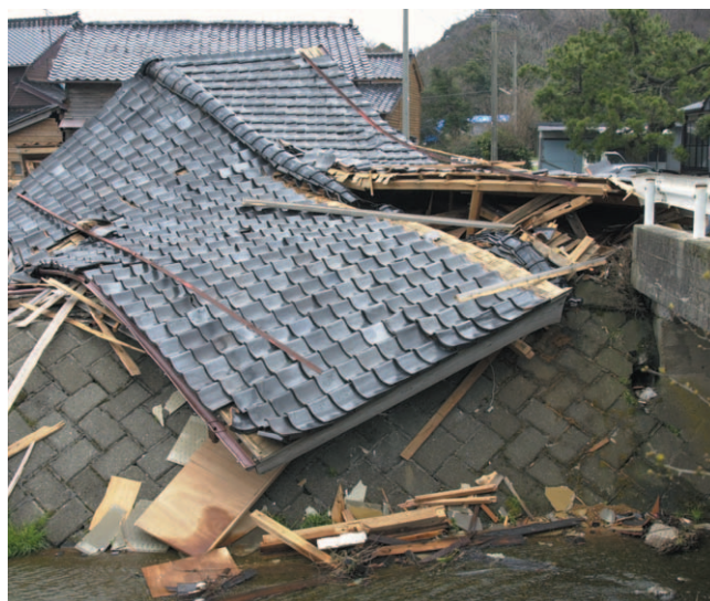
写真-6 道路を塞いで倒壊した土蔵(輪島市門前町道下)
