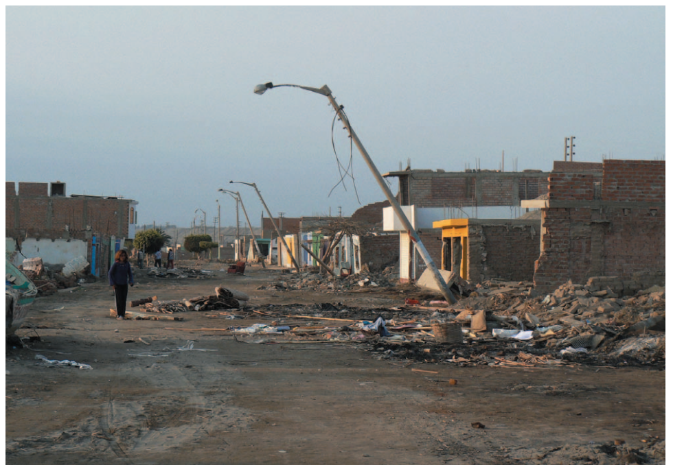
写真1 タンボ・デ・モラの街路の被害の様子。まちは液状化によって、70cm以上沈下し、90%以上の建物が影響を受け、5人の死者が出るなど、大きな被害を受けた
