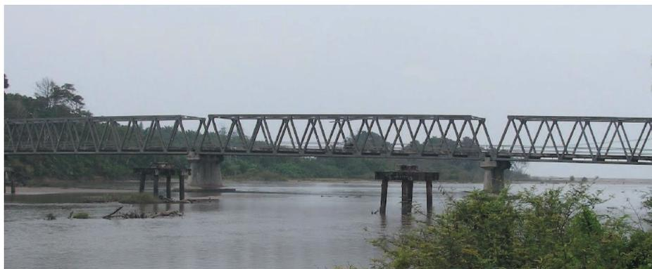
写真5 地盤の液状化に伴って不等沈下が発生したSeblat川トラス橋
