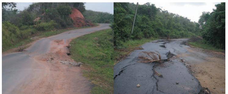
写真7 斜面と盛土の崩壊による道路被害
