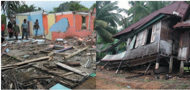
写真3 れんがが積みおよび木造家屋の崩壊
