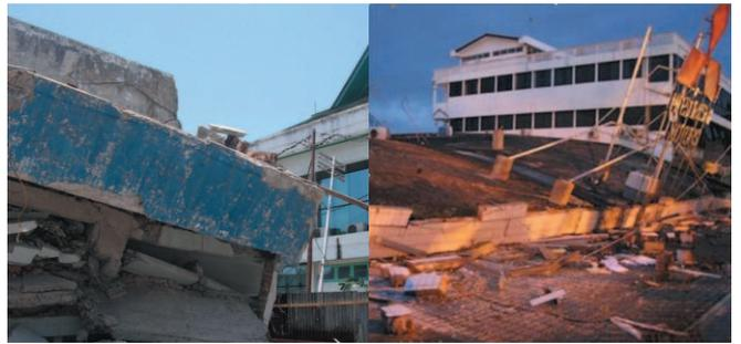
写真2 パダン市におけるRC構造物の崩壊
