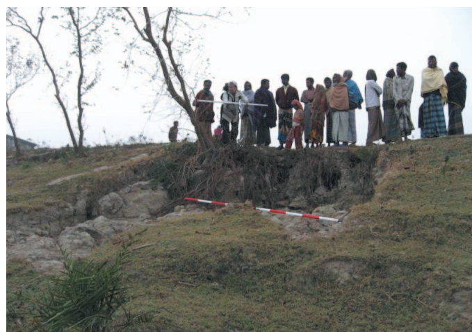
写真7 West Kuakataにおける堤防上陸側の樹木についての浸水痕跡。堤防陸側は海側よりも勾配が小さく、局部的に洗掘の跡が見られる
