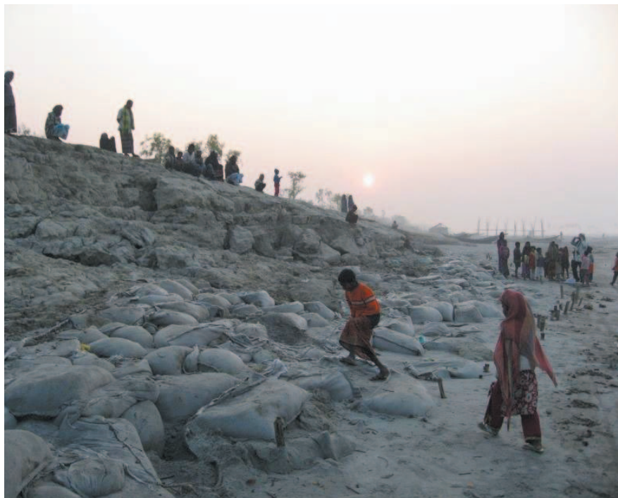
写真8 West Kuakataにおける堤防海側前面では、一部で土嚢袋が露出していた
