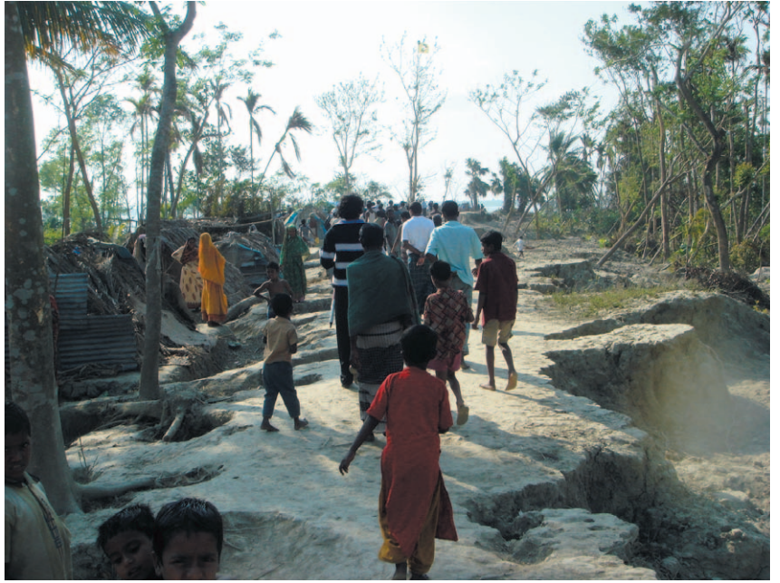
写真4 Mathbaria郡Sapleza村のsea dike: 左側がBaleswar川で堤防上を2mの高潮が乗り越えた。堤防法面(左)上に土地をもたない居住者の仮設テントが並んでいる
