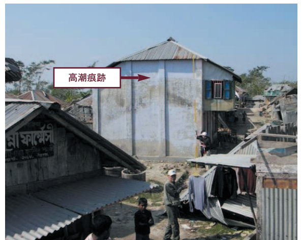
写真3 Mathbaria郡 Bandapfara Bazarにおける堤防道路そばのコンクリート家屋。2階窓の上まで冠水しており、周辺の1階建て家屋はすべて水没した
