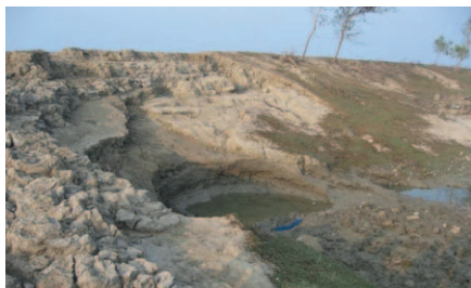
写真9 West Kuakataにおける堤防陸側でと ころどころに見られた局所洗掘跡
