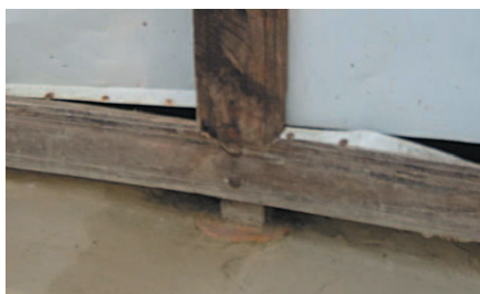
写真10 West Kuakata堤防背後の漁師家屋の 基礎部分は土台上に載せられているだけ で土台上水深約25cmの氾濫流により約 1m流されたが、家屋の崩壊は免れた
