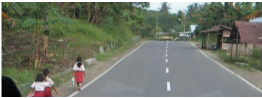
写真2 道路の拡幅としっかりした舗装で復旧した道路
