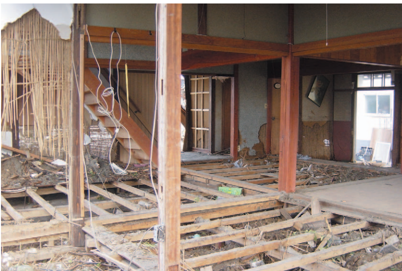
写真3 入善町芦崎地区における住宅地の浸水被害(提供:名古屋大学川崎浩司准教授)
