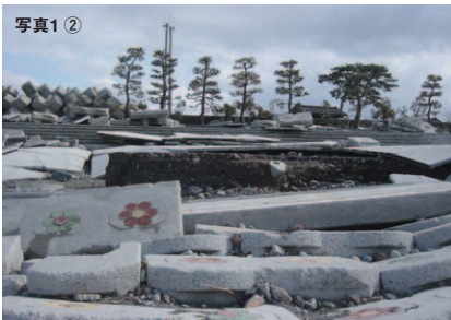
写真1 入善町芦崎地区の被害の様子 ①植生の無惨な姿、②緩傾斜護岸の堤防ブロック(2×1×0.5m)の散乱、③離岸堤の消波ブロックの流出(提供:名古屋大学川崎浩司准教授)
