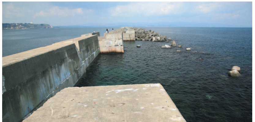
写真4 伏木富山港(伏木地区)防波堤(北)のケーソンの滑動・傾斜(横から) ケーソンの滑動・傾斜だけでなく、防波堤前面部に設置されていた消波ブロックも沈下している(提供:京都大学防災研究所 間瀬肇教授)
