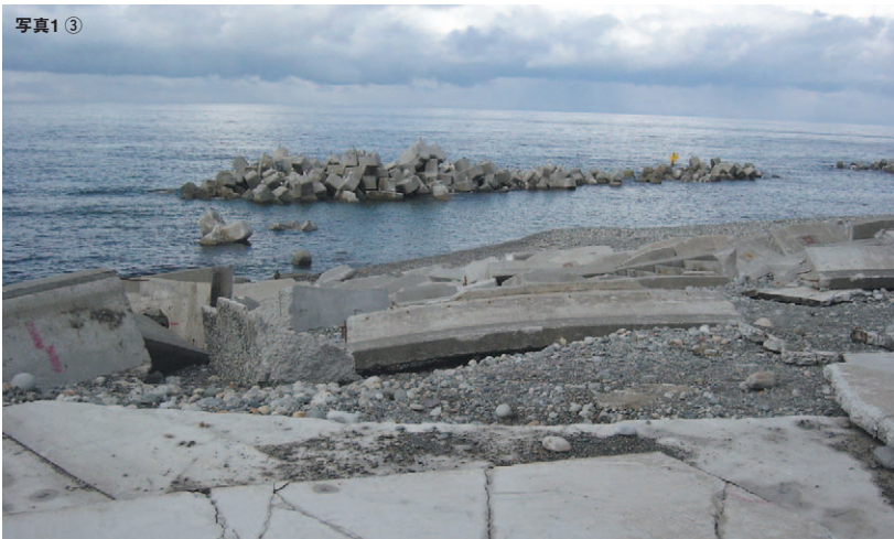
写真1 入善町芦崎地区の被害の様子 ①植生の無惨な姿、②緩傾斜護岸の堤防ブロック(2×1×0.5m)の散乱、③離岸堤の消波ブロックの流出(提供:名古屋大学川崎浩司准教授)
