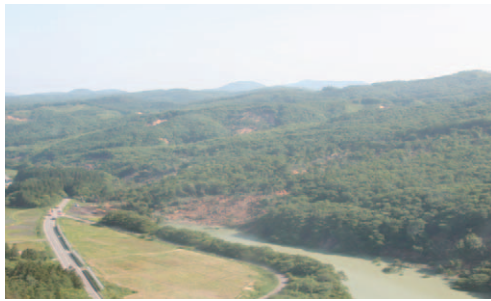
写真5 磐井川沿いの一関市市野々原地区の天然ダム (調査団6月18日撮影)
