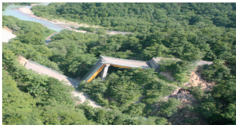
写真1 祭時大橋の破壊状況 (調査団6月18日撮影)
