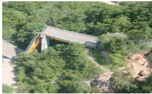
写真2 祭時大橋秋田側の背後斜面の崩壊と道路の亀裂(調査団6月18日撮影)
