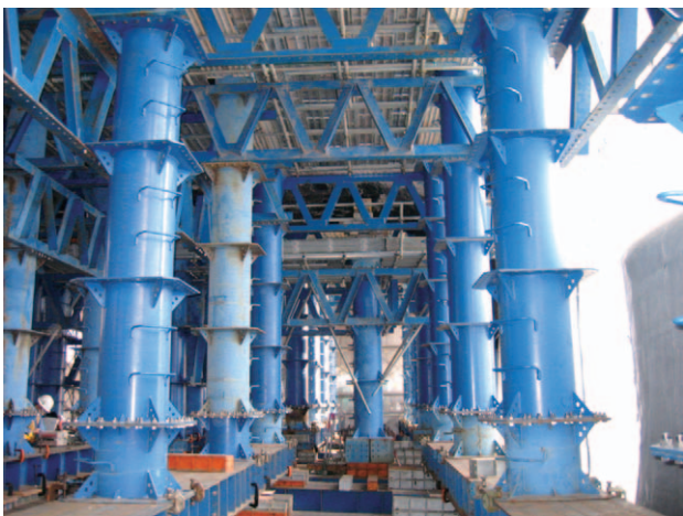
写真1 仮受けベント設置状況
