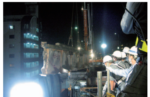
写真2 鋼主桁撤去状況【ステップ1】
