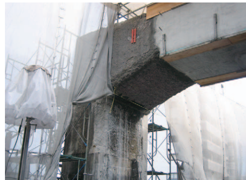
写真4 橋脚補修状況
