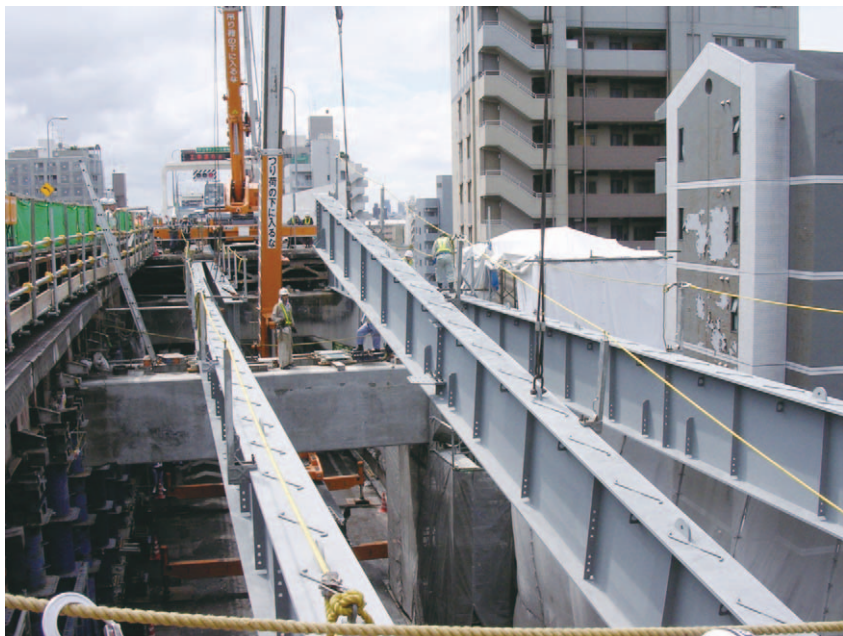
写真5 鋼主桁架設状況【ステップ1】
