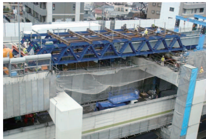
写真6 鋼主桁架設状況【ステップ2】
