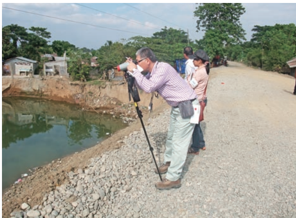
写真5 修復した堤防から堤内を見た様子。陥没は大きなところで深さ10mもある
