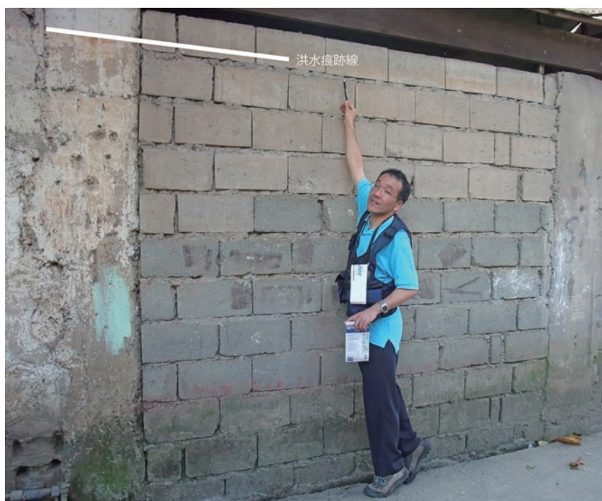
写真3 マリキナ川沿いの住宅地の洪水痕跡。2mを超えている
