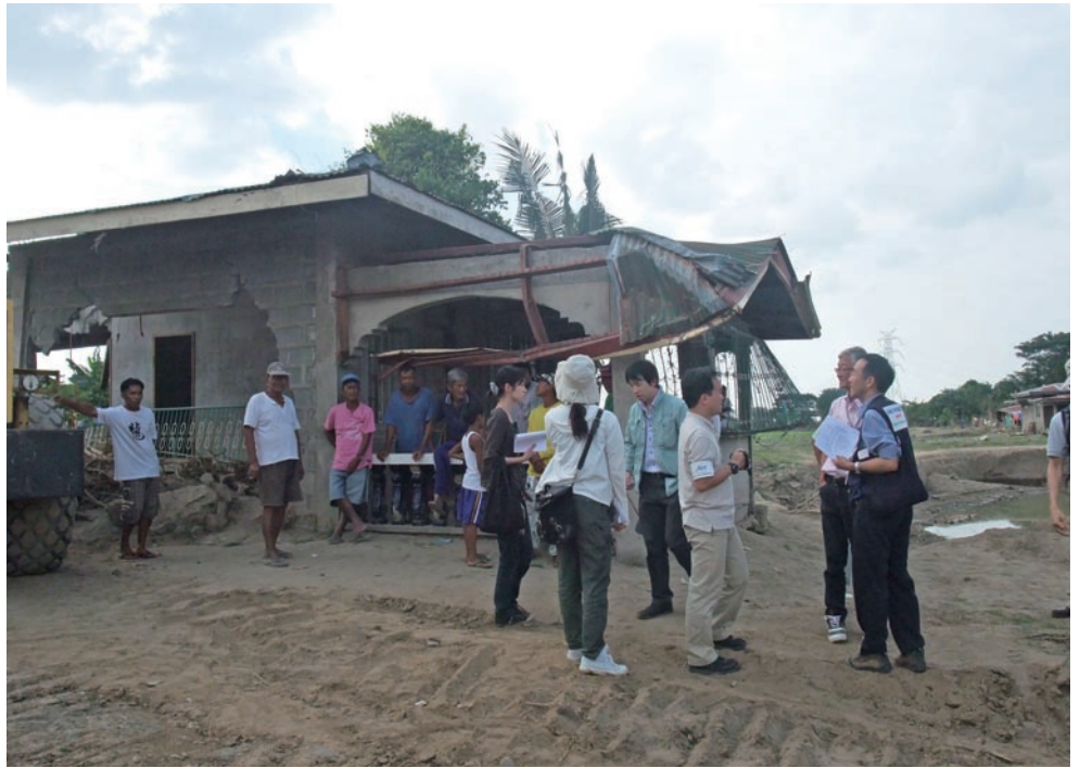
写真4 アグノ川の破堤個所の堤内側。流体力で家屋が破壊し、その右に陥没穴が見える
