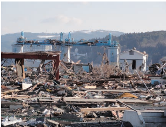
南三陸町の水門 津波来襲時には水門を閉じ市街地への津波の侵入を防ぐはずであった。しかし、津波は水門をはるかに超えてまち全体を破壊し尽くした(撮影：越村俊一准教授)
