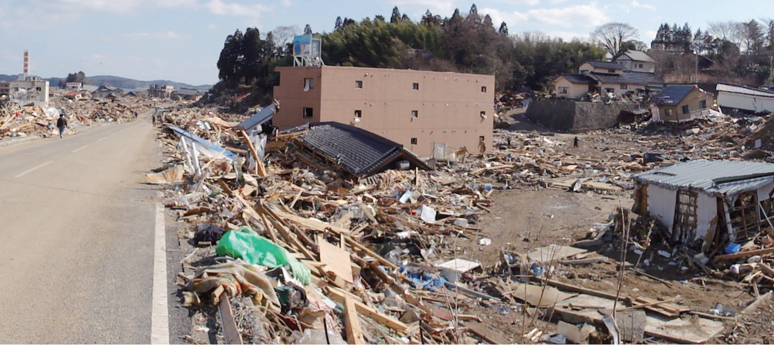
気仙沼市松岩地区の被害状況 すべての家屋をなぎ倒し、残されたのはがれきのみであった(撮影:越村俊一准教授)
