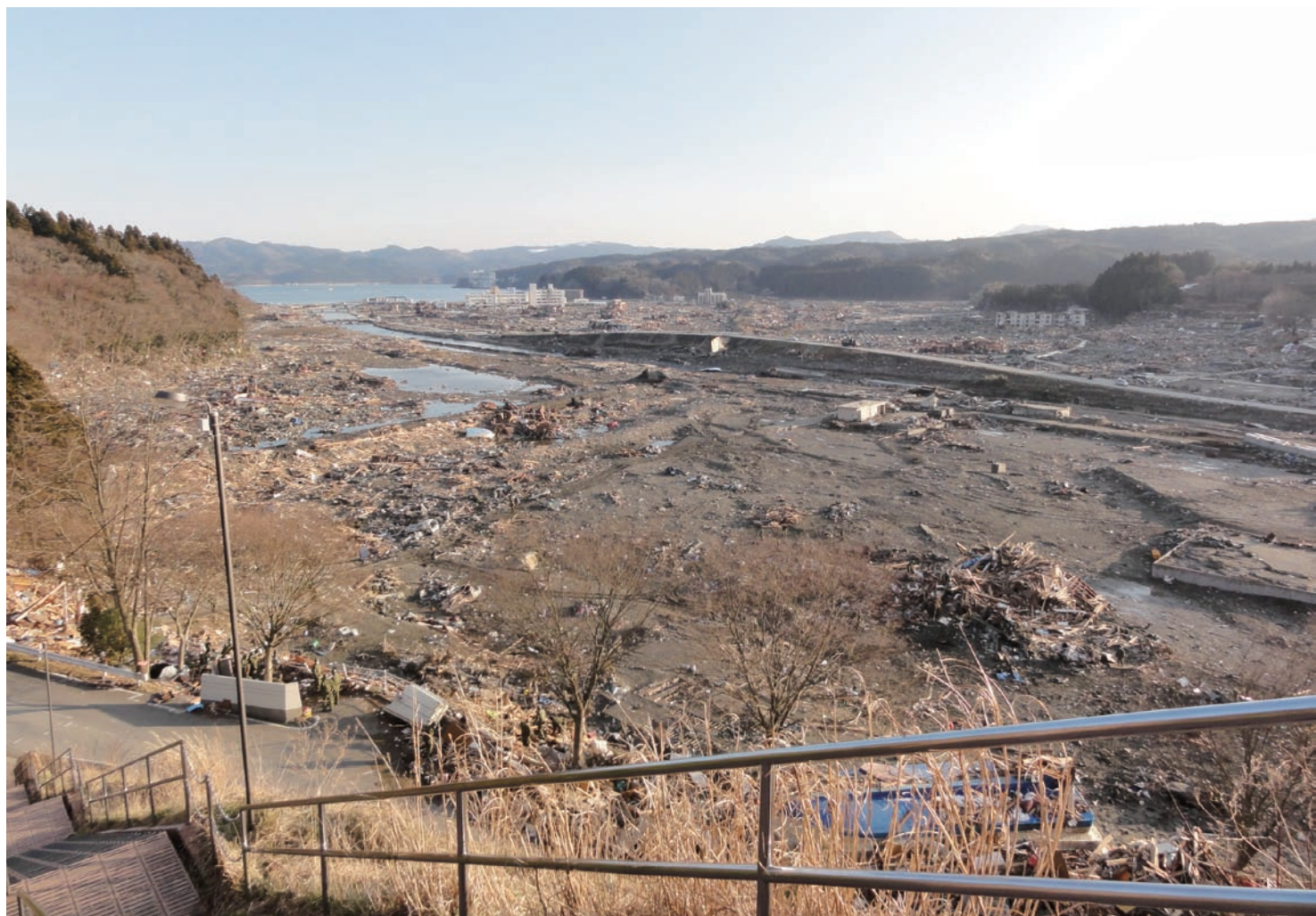
南三陸町の高台の上から撮影 海岸の鉄筋コンクリート造の建物を除き、ほとんどの建物が流失してしまった。南三陸町は地震により75cm程度の地盤沈下が発生したと報告された(撮影:越村俊一准教授)
