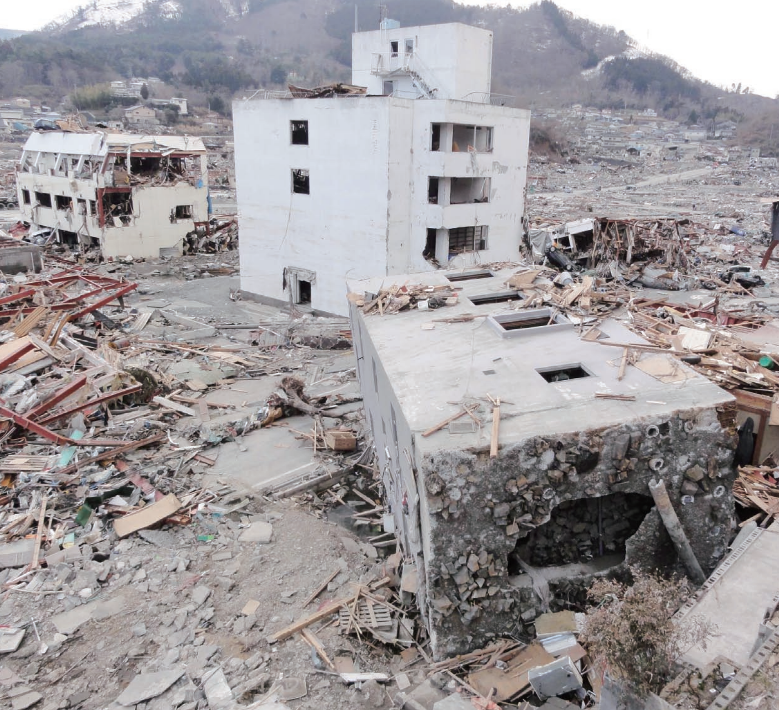
転倒した女川町内の鉄筋コンクリートビル 地震により杭の支持力が失われ、その後襲った津波により転倒したと考えられる。これまでは、鉄筋コンクリートのビルは津波に耐えると言われていた。奥のビルの屋上には自動車が残っている(撮影:越村俊一准教授)
