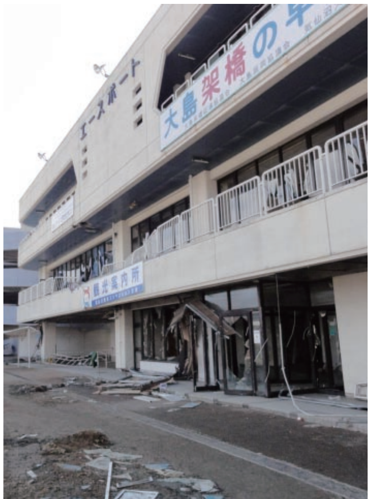
気仙沼湾奥(南町)の船着場 津波は2階部分まで浸水した。津波は気仙沼市役所まで浸水した(撮影：越村俊一准教授)
