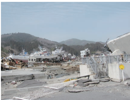
気仙沼市鹿折地区の被害状況 大型漁船等が手前の防潮堤などの防護ラインを破壊し、市街地奥まで津波により打ち上げられている。船舶に加え、石油タンク、木材、養殖いかだ、車両などは漂流物となって被害拡大の要因の一つになっている(撮影：今村文彦教授)
