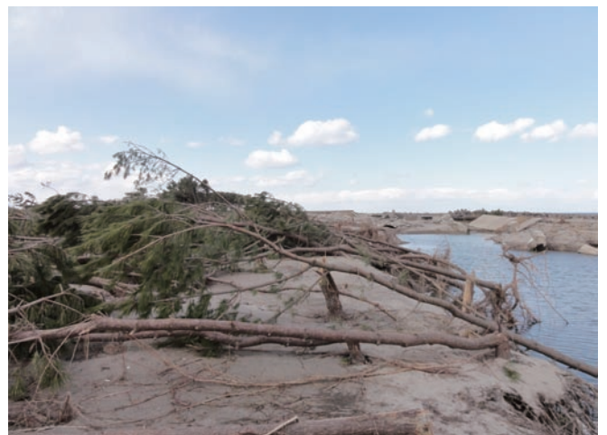
鳥の海の防潮堤と海岸林の被災状況 津波の防護と減勢が期待されていた防潮堤と海岸林であるが、その被害状況は甚大であった。写真の水域では津波により洗掘された地盤に海水が滞留している(撮影:今井健太郎助教)
