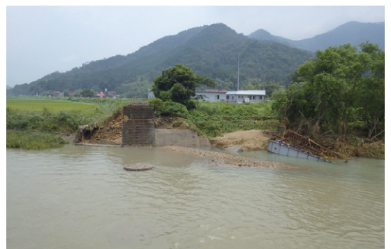
写真2 鉄道橋の流失
