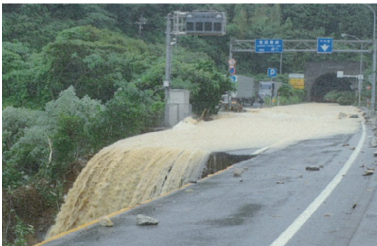
写真5 須佐トンネル坑口近くの道路崩壊
