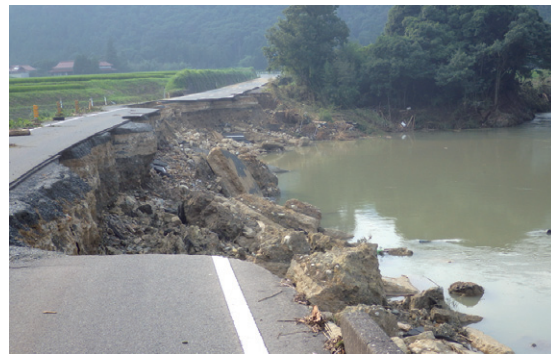
写真1 崩壊した国道315号線
