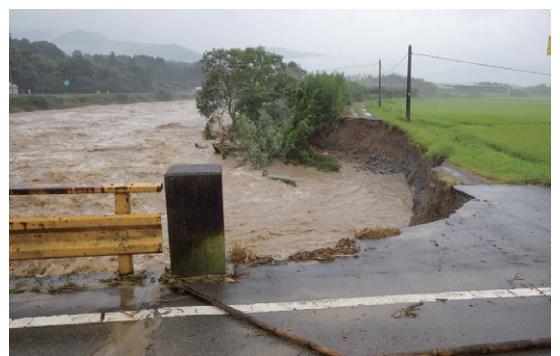
写真3 橋梁直下流の護岸崩壊
