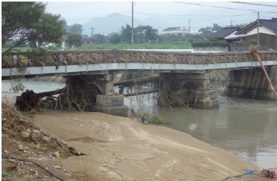
写真4 橋脚の不同沈下
