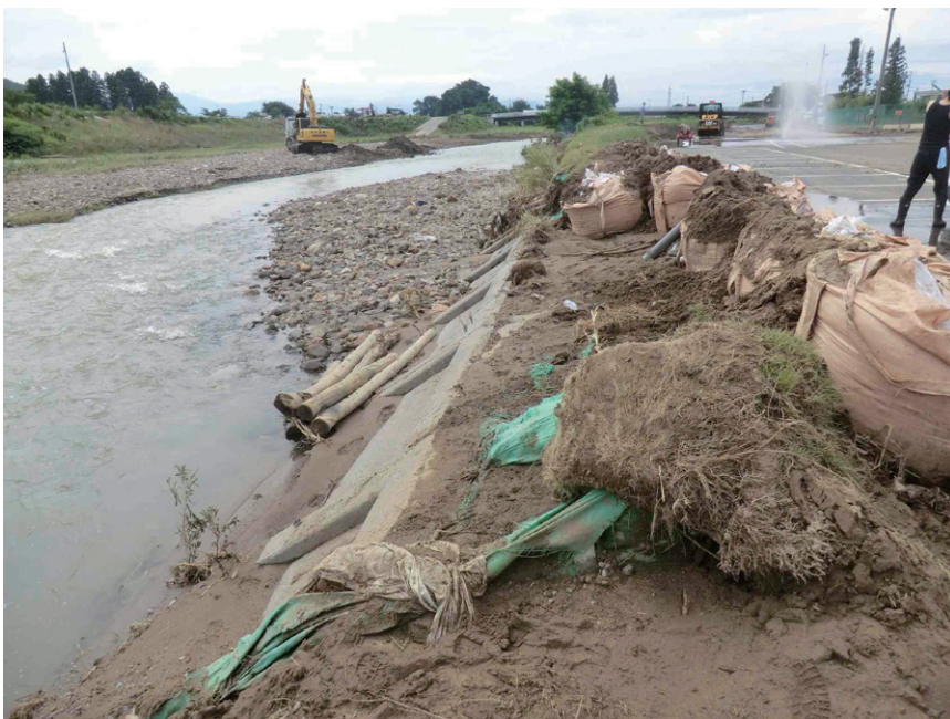
写真1 赤湯自動車学校土堤の欠壊 (撮影:小森大輔、7月21日撮影)
