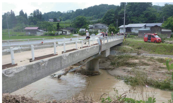
写真2 久保橋の冠水により一時孤立した集落 (撮影: 呉 修一、7月21日撮影)
