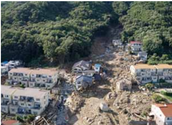
写真2 八木3丁目県営緑ヶ丘住宅の上の溪流で発生した土石流による被害の状況(無人ヘリコプターによる空撮、ルーチェサーチ(株))
