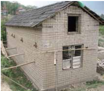
PP-バンド補強2階建てアドベ（泥モルタル）組積造（2009年） 地震後の様子（2015年、周辺の焼成レンガ組積造が被害を受けている中で）
