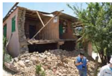
石積み組積造（泥モルタル）建物の被害
