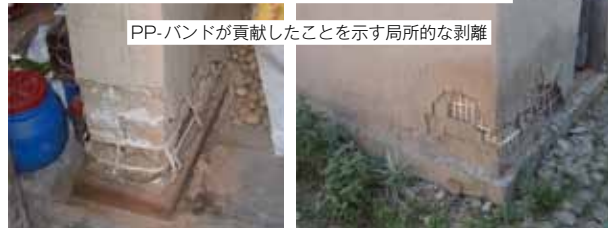
PP-バンド補強2階建てアドベ（泥モルタル）組積造（2009年） 地震後の様子（2015年、周辺の焼成レンガ組積造が被害を受けている中で）
