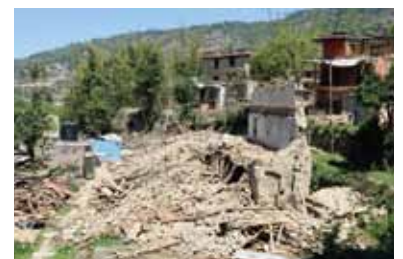
アドベ組積造（泥モルタル）の被害
