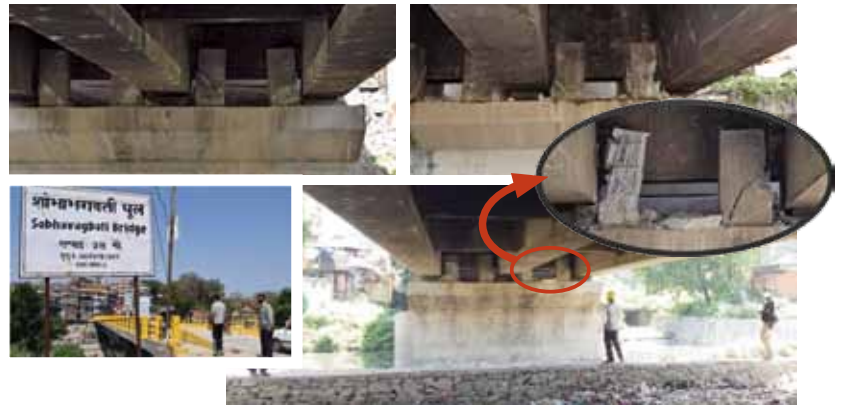
橋桁のずれ止めのせん断破壊 (左上：北側取付部、右上：南側取付部、右下：橋脚上の取付部)
