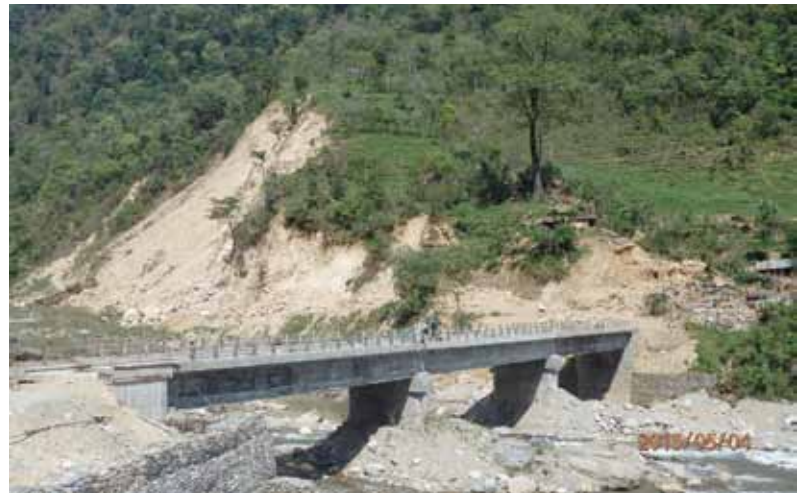
写真3 震源地付近で発生した斜面崩壊 (N28°10'13.57"、E84°42'18.23")
