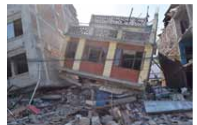
RC構造の被害 (柱梁の接合部分が弱いため、RC柱もRC梁も強度を十分に発揮する前に崩壊している)
