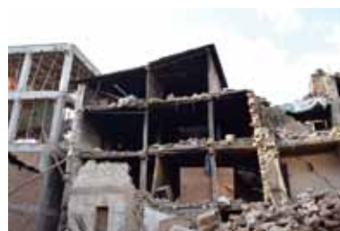
非補強焼成レンガ組積造建物の被害 (床を支える木製の柱、壁は組積壁。隣のRC構造は、細い柱梁でも被害を免れた)
