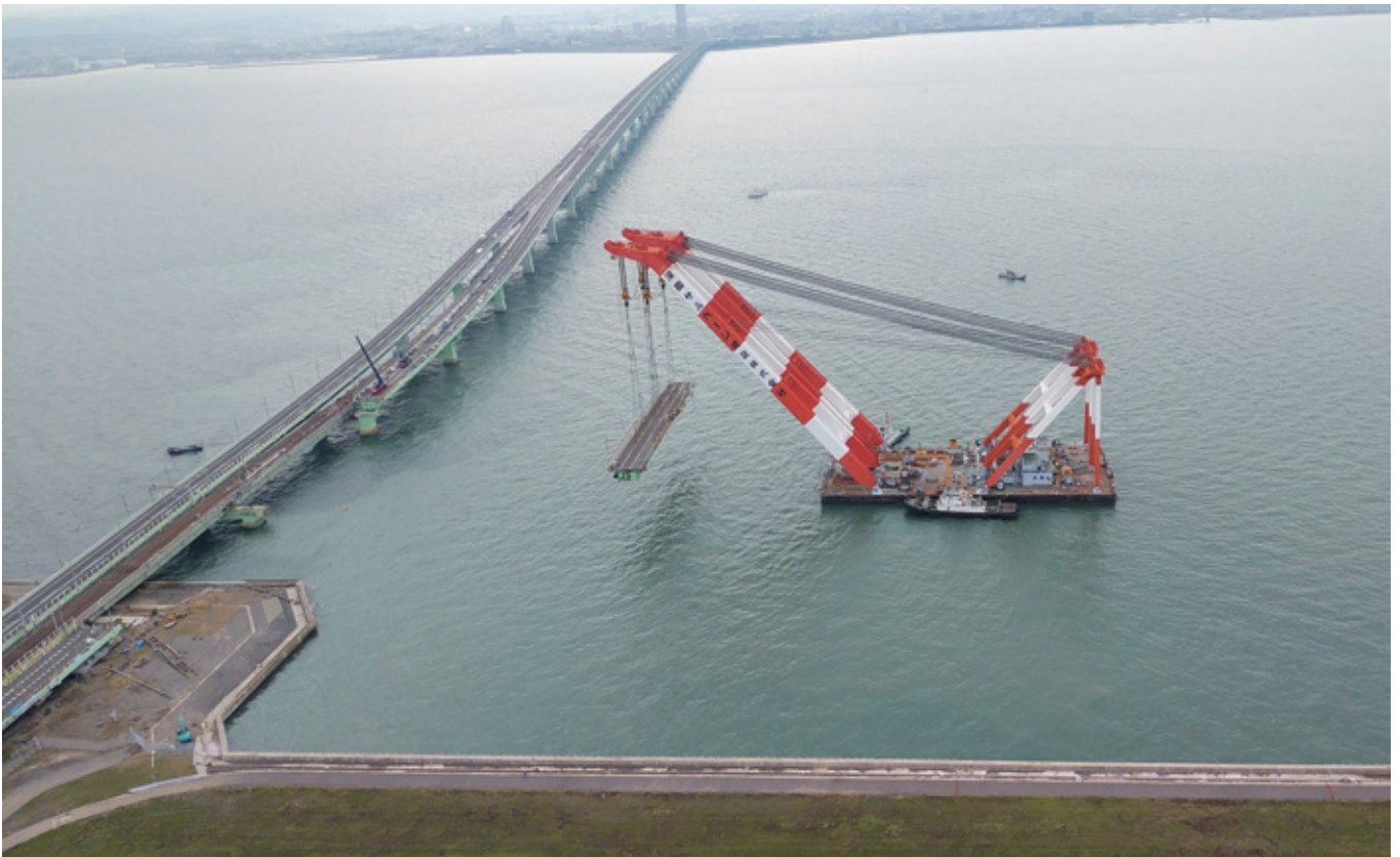
写真1 タンカーの衝突により損傷した関西国際空港連絡橋橋桁のクレーン船による撤去状況 (写真提供：西日本高速道路(株))
