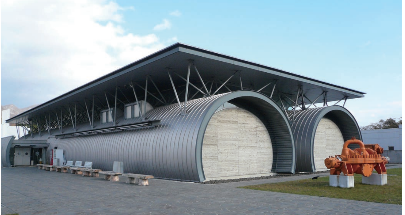
トンネルをイメージした記念館の外観
