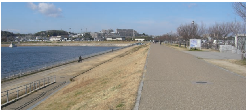
堤体と狭山池
