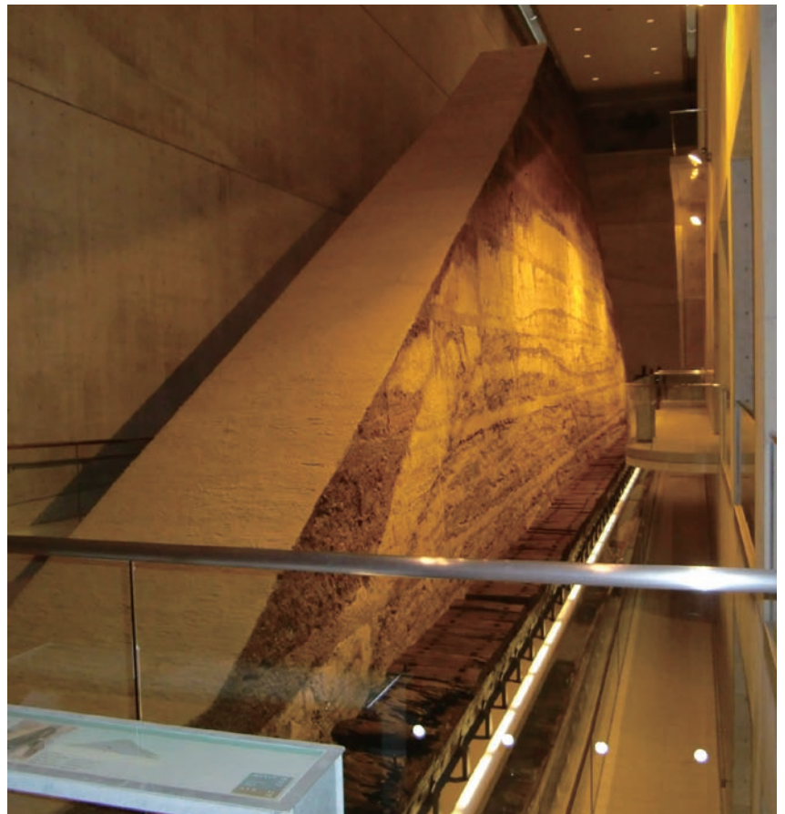
平成の大改修で切り出した堤体断面
