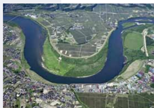
2009年6月撮影(下流側樹木伐採)
