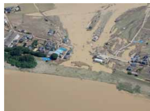
写真1 2015年9月関東・東北豪雨における鬼怒川の堤防決壊の状況 (茨城県常総市、出典：国土交通省)
