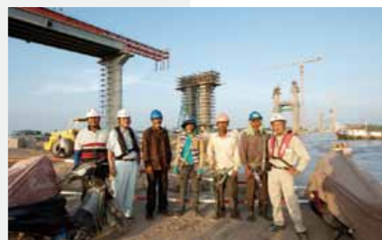
写真3 メコン川にかかる橋梁の建設現場のスタッフ(カンボジア)(写真提供:久野真一/JICA)
