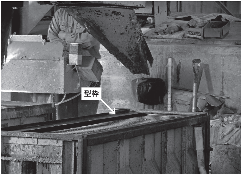
写真2 型枠にコンクリートを流している様子
