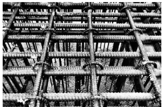
写真1 生コンと美しく組まれた鉄筋
