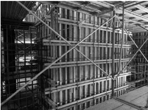
写真2 真っすぐに設置された型枠
