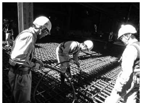
写真4 バイブレーターを使って締めを体験!
