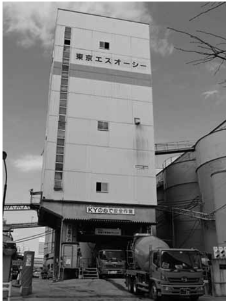
写真1 生コン製造のためのプラント
