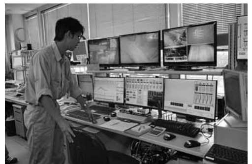
写真2 原材料供給および計量制御・生コン製造の操作盤
