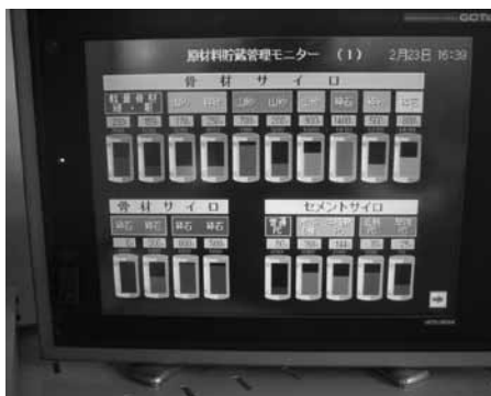
写真3 原材料在庫管理モニター
