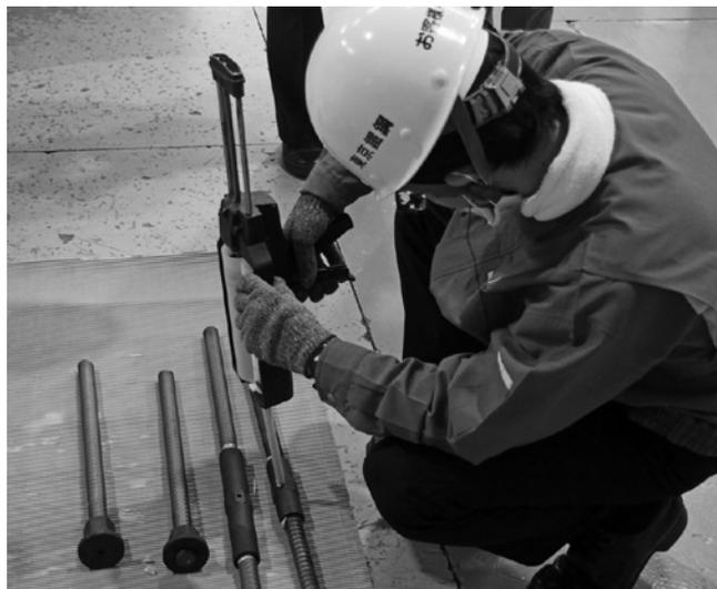
写真4 鉄筋を接続したジョイントに接着剤を注入する筆者
