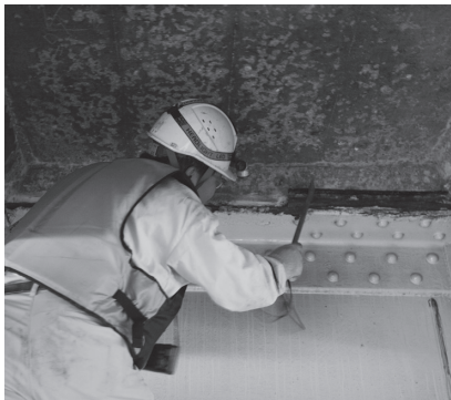
写真2 桁下での点検風景
