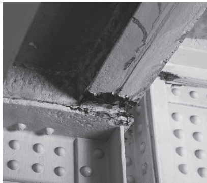
写真3 点検で見つかった部材の腐食
