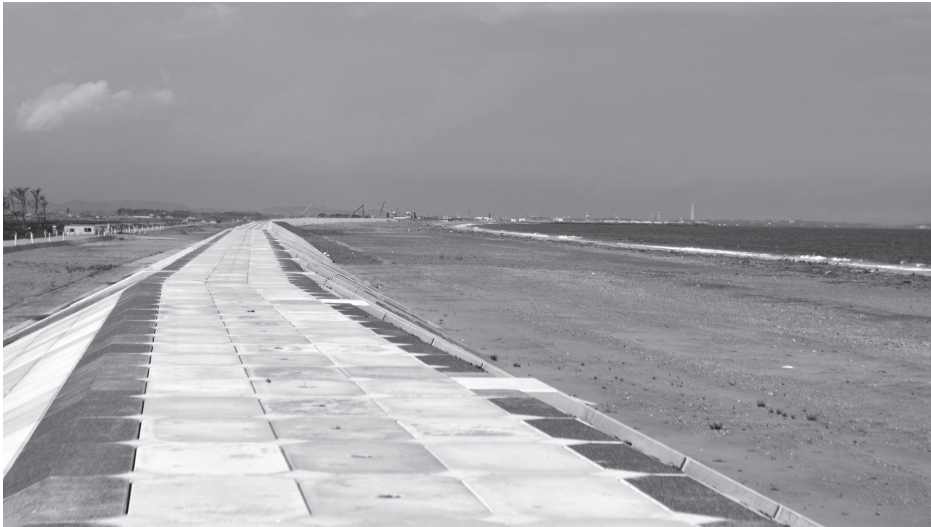
写真2 復旧された海岸堤防
