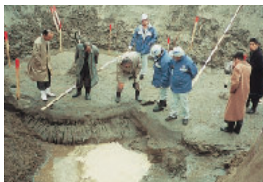
写真-3 薬液注入試験施工の掘削検証（超微粒子シリカ、ゲルタイム8時間、浸透注入、浸透範囲200cm以上、液状化対策のため必要強度は5〜10kPaに設定）
