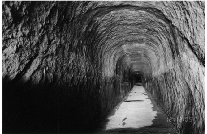
高さ6尺(約1.8m)、幅4尺(約1.2m)、長さおよそ1kmにも及ぶこの隧道は、開通以来、素掘の随道のまま生活道路として村の暮らしを助けてきた。1998(平成10)年に新中山トンネルが開通して、約半世紀の役目を終えた。
