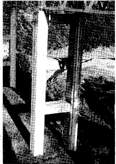
写真-1 多層RCラーメン橋脚
