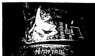
写真2 支承の下フランジ貫通例 (端支点の可動支承、箱桁内を撮影)
