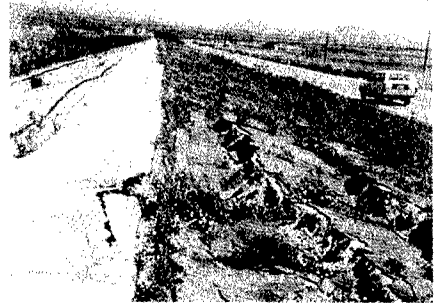
図-1 八郎潟堤防の破壊
