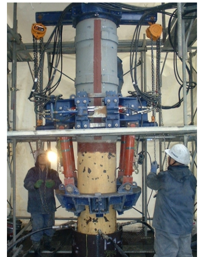
写真-1 施工状況
