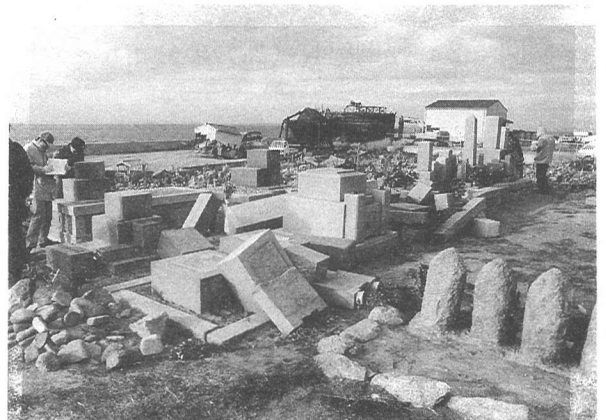
写真-1 墓石転倒状況例（北淡町野島橋墓地） （転倒率100%）
