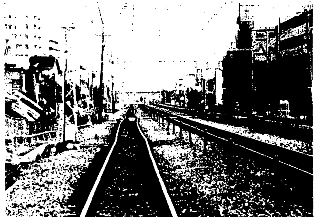
写真. 8 JR線摂津本山駅東側でのレールの屈曲
