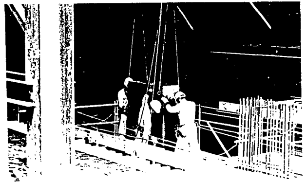
写真-2 角形鋼管中柱の施工状況
