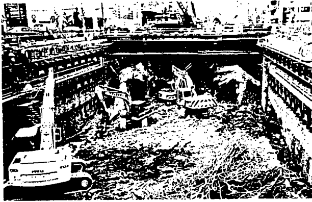
写真-1 躯体の取壊し状況
