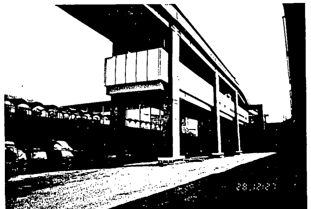
写真-1 被災後のポートターミナル駅
