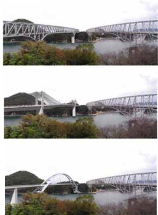
写真 - 3.1 2 次抽出案の 3 橋 (上：鋼連続トラス橋(現橋と同形式) 中：鋼 PC 複合エキストラロード橋 下：鋼 PC 複合中路アーチ橋) 2)
