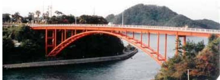
写真-2.4 天草5号橋(松島橋)
