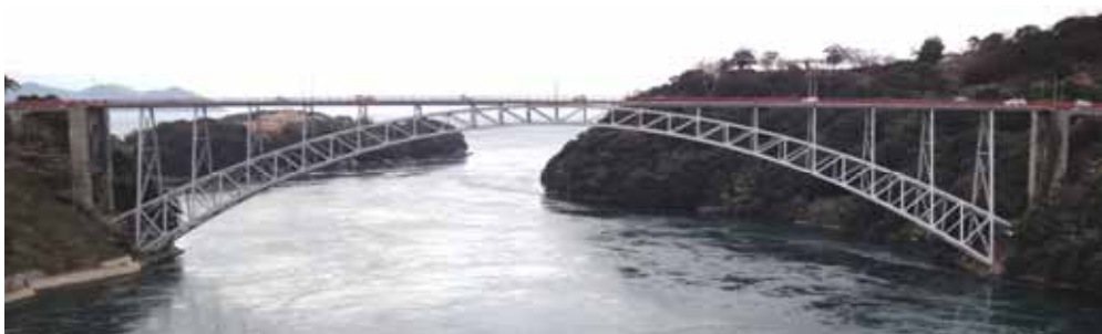
写真 - 1.1 針尾瀬戸に架かる西海橋
