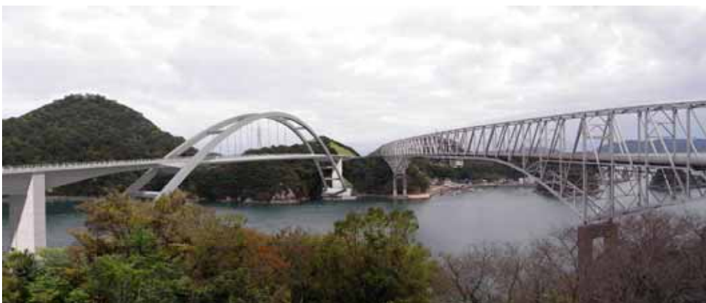
新天文橋のアーチの明度は補剛桁よりわずかに低いが、現天門橋とは調和している。
