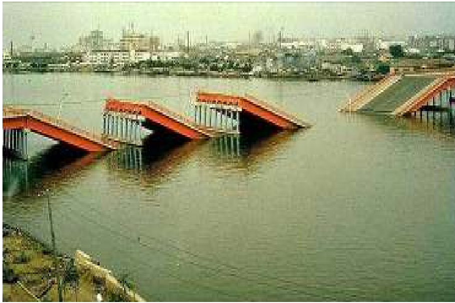
1964新潟地震 昭和大橋の落橋
