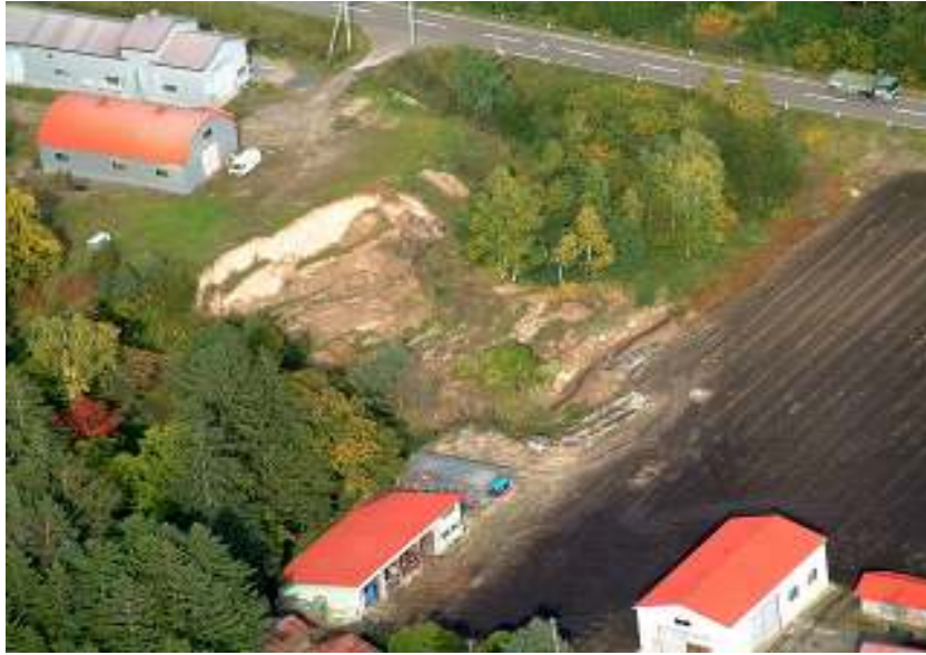
クッチャロ軽石流堆積物の盛土崩壊 (2003年十勝沖地震 北見市広郷)
