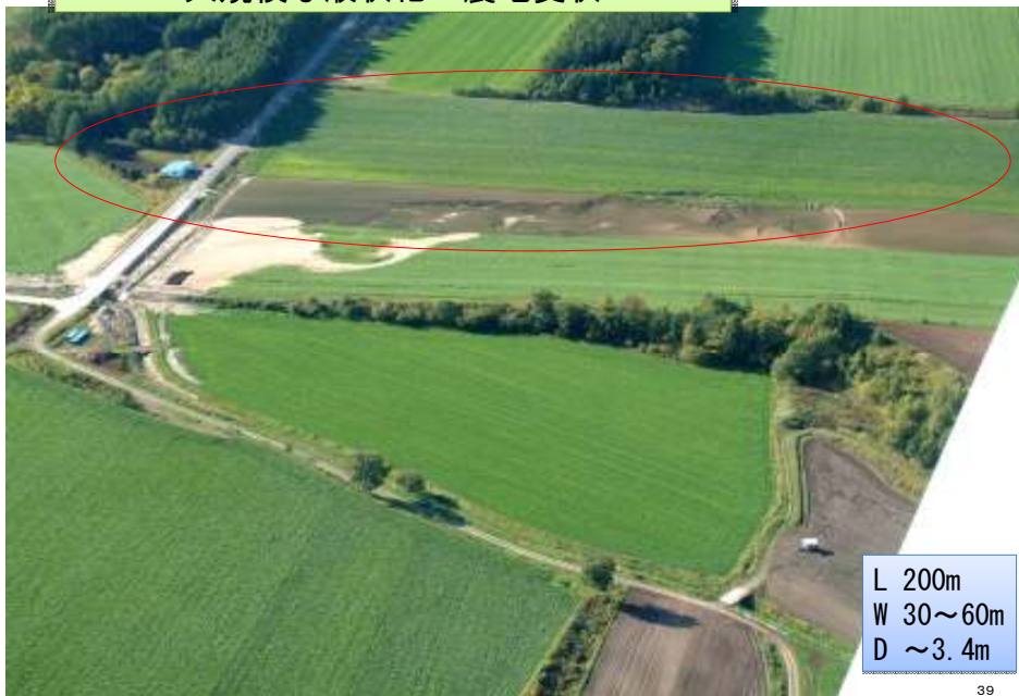
(2003年十勝沖地震 端野町協和地区) 大規模な液状化・農地変状
