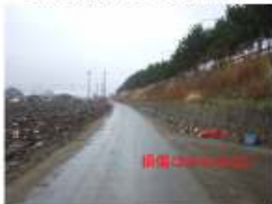
盛土のり尻部のブロック積み状況
