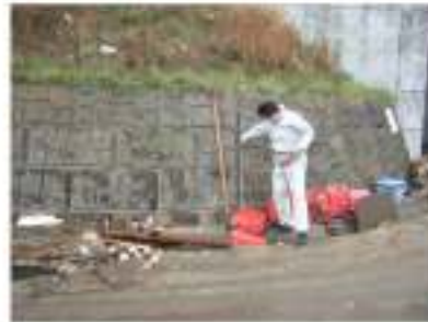
カルバートボックス巻き込みブロック積み
