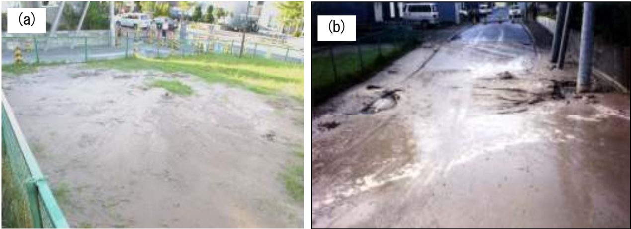
写真－1 火山灰地盤の液状化
