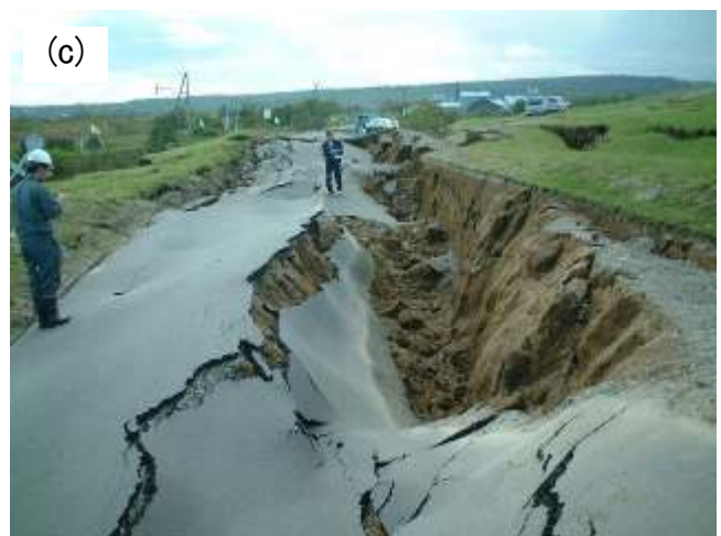
写真－3 十勝川水系の堤防崩壊の様子
