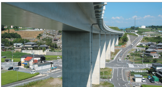
写真2 垂井高架橋の全景
