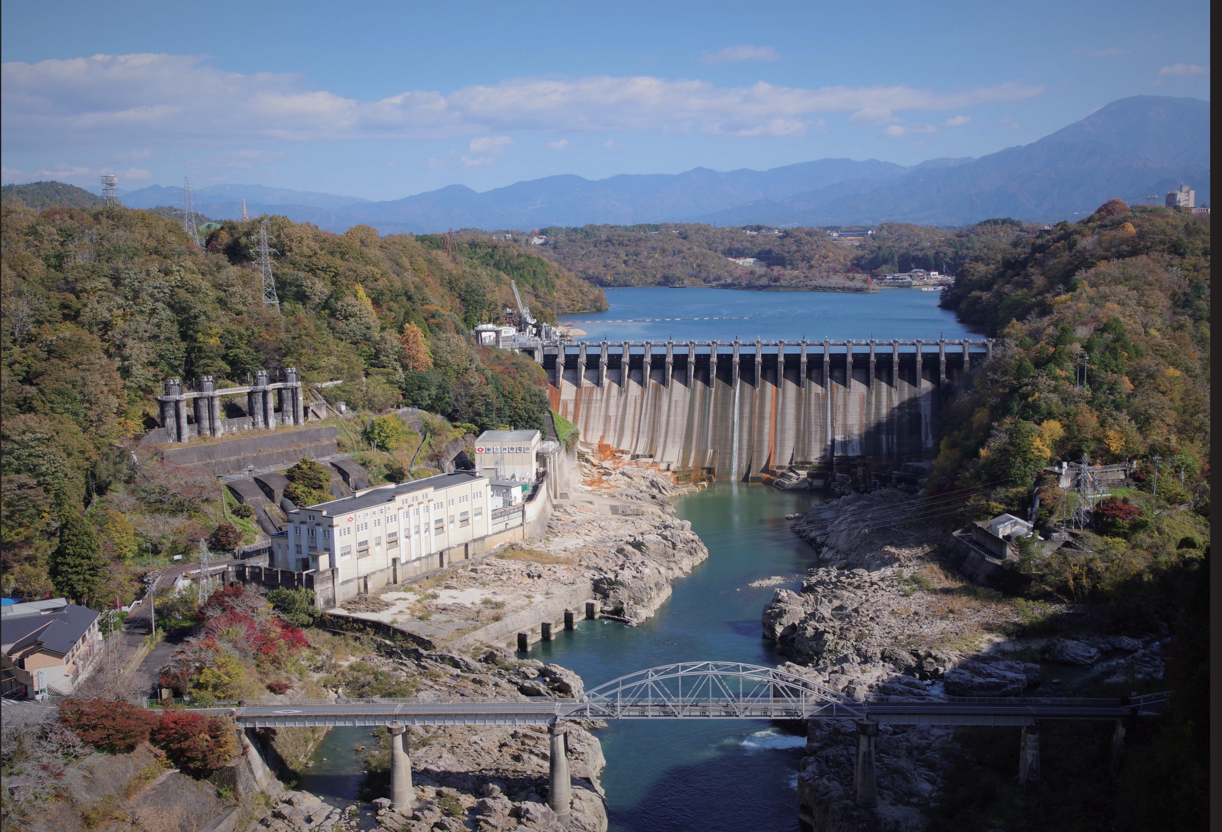
▲ 左から大井発電所、新大井発電所、大井ダムを眺める。手前の東雲橋からの展望が素晴らしい。ダム貯水池は恵那峡で、遊覧船から堤体を眺めることができる。また、後ろには恵那山がそびえたつ。
