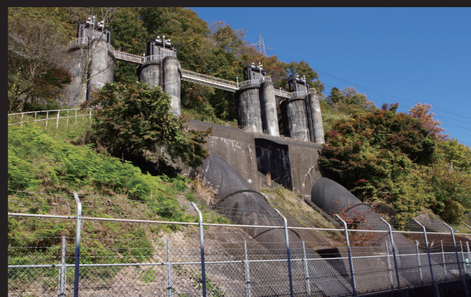
▲ サージタンクと水圧鉄管
