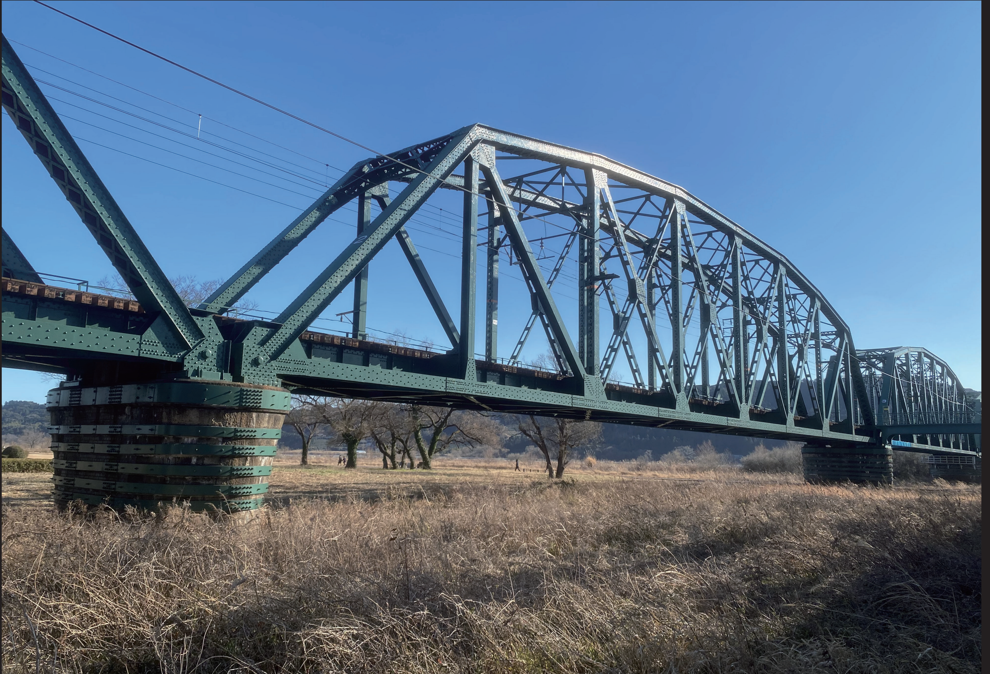
▲ 大井川の左岸側の高水敷は緑地公園で、地元住民の散歩道にもなっており、大井川橋梁を間近に見ることが可能
